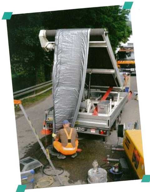
Mise en place de la gaine
