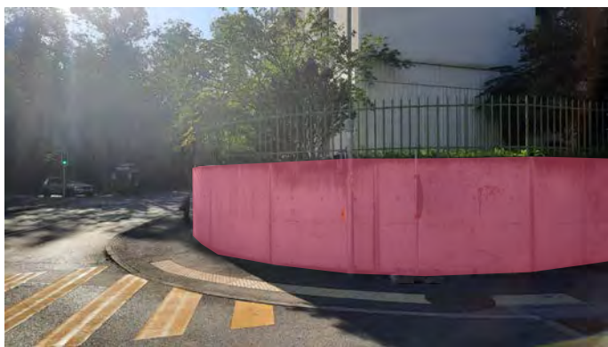
Carrefour route de Chancy / chemin du Vieux-Chêne
