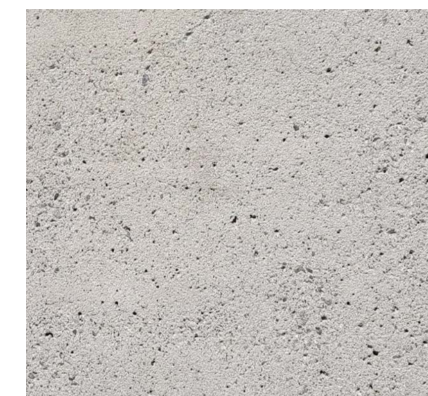
Référence couleur et traitement sablé de béton
