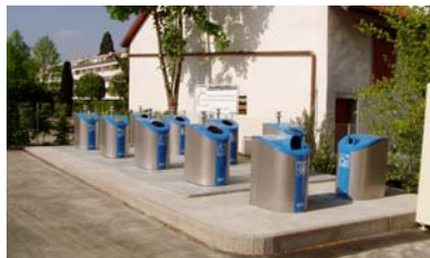
Déchetterie du chemin des Courtillets, au Grand-Lancy.
