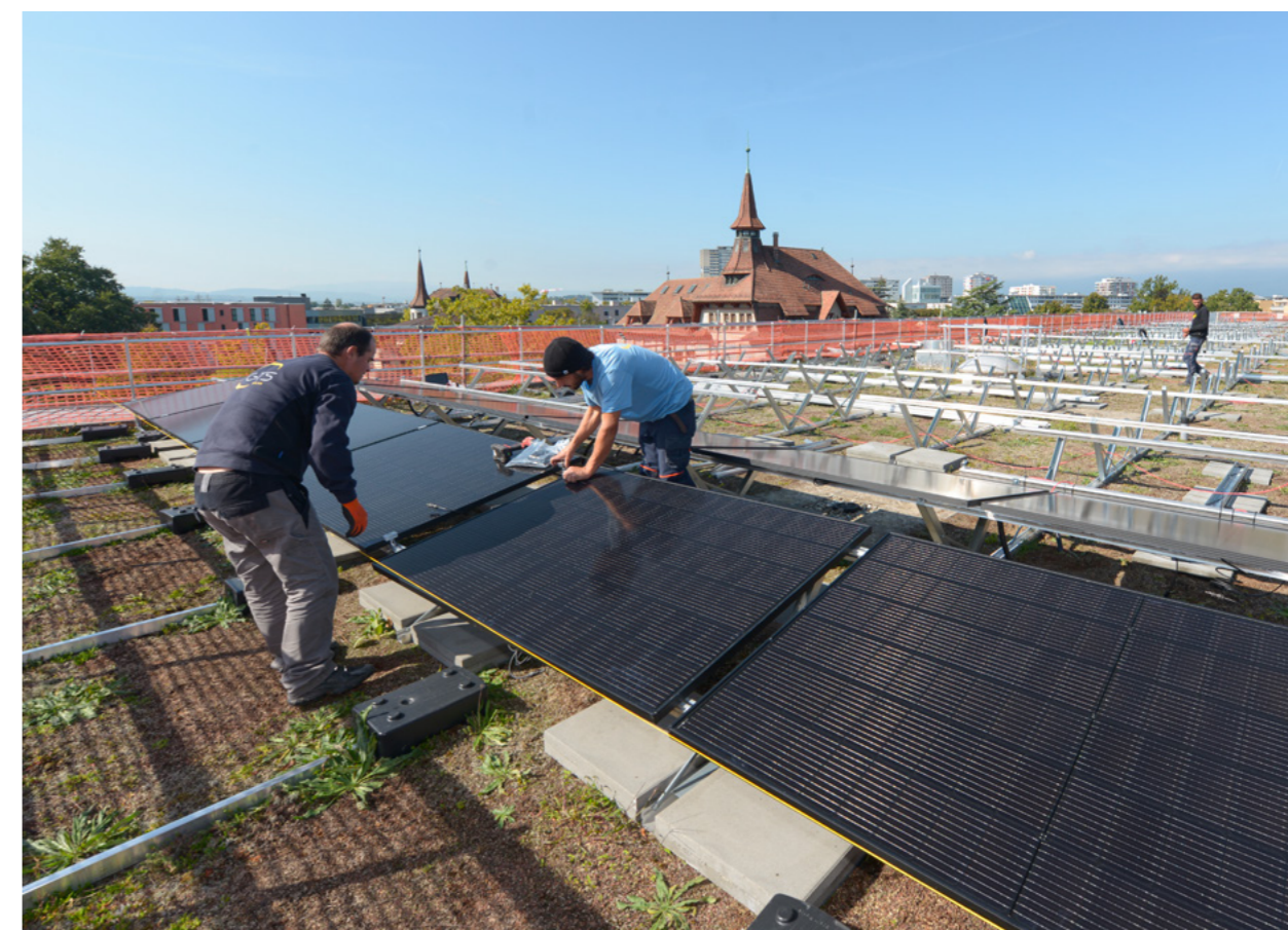
École du Petit-Lancy, Avenue Louis-Bertrand 7, 1213 Petit-Lancy, installation des panneaux solaires photovoltaïques, 2025
