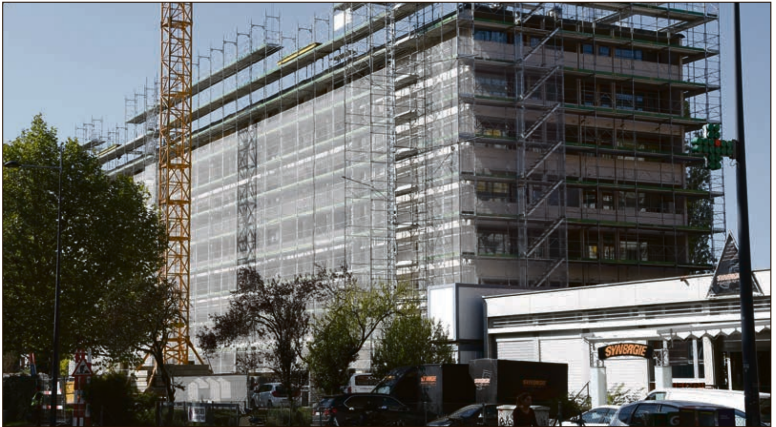
L'immeuble des Rentes Genevoises, au Petit-Lancy, en cours de rénovation.
