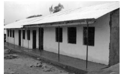
Le bâtiment terminé
