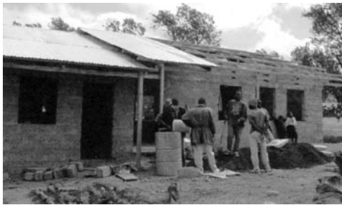
Des salles de classe de l'école d'Olturoto en construction
