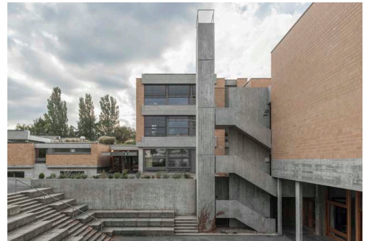
Ecole des Palettes | © Clivaz Architectes
